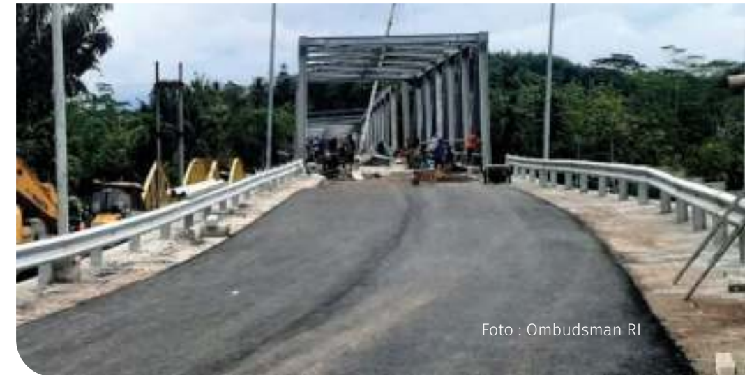
Proses pembangunan jembatan baru Cibuni
