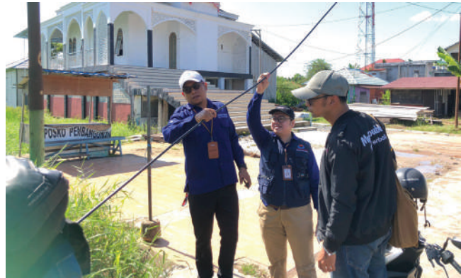
Tim Perwakilan Ombudsman RI Provinsi Kalimantan Selatan saat melakukan pemeriksaan lapangan terkait kondisi kabel fiber optic yang banyak menjuntai
